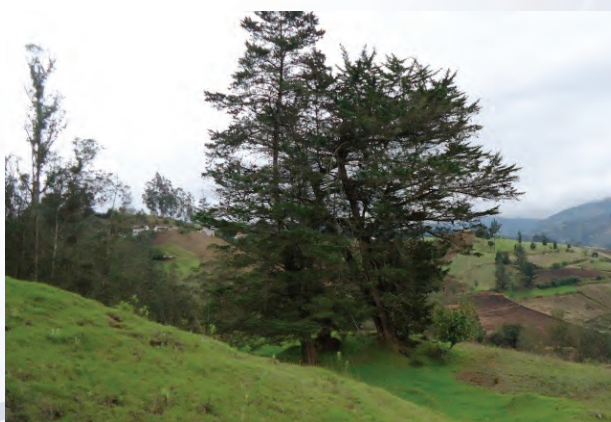
Figura 7.- Árboles inclinados y troncos curvos por deslizamiento rotacional.
