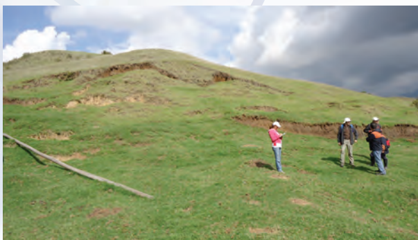
Figura 12.- Cicatrices de deslizamiento en ladera no cultivada.
