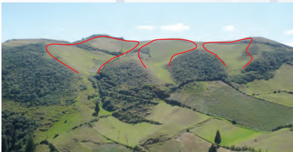
Figura 2.- Cicatrices de antiguos deslizamientos en la zona de divisoria.
