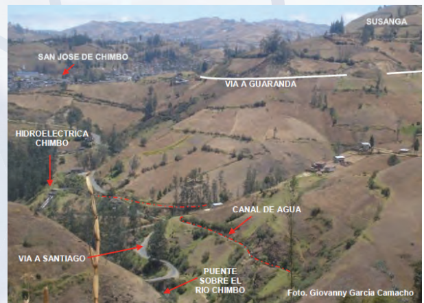
Figura 44.- Elementos expuestos en el flanco sureste.
