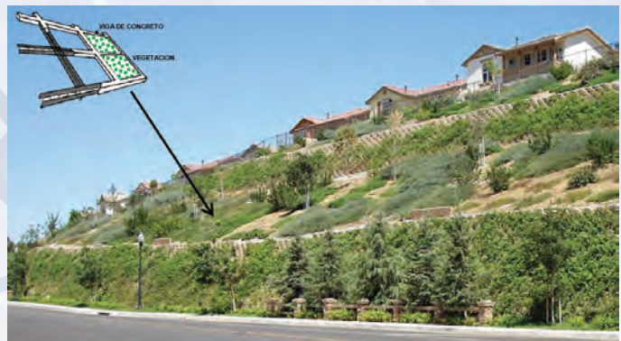
Figura 51.- Vigas de hormigón armado para confinar la vegetación.
