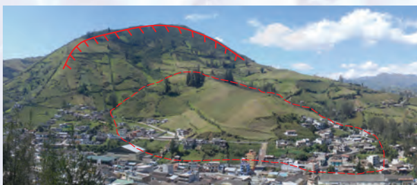
Figura 10.- Deslizamiento del flanco sur del cerro Susanga.
