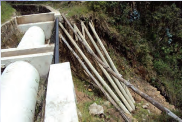
Figura 45.- Apuntalamiento del canal de agua para afianzar su posición.
