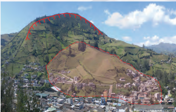
Figura 46.- Vista Panorámica del Flanco Sur del Cerro Susanga con la masa deslizada y su cicatriz. Se puede apreciar la vía panamericana y los barrios Crus Loma, El Guabo, Shamanga y San José.
